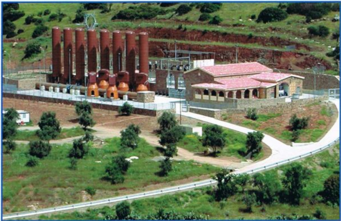
Veduta dell'impianto da sud
