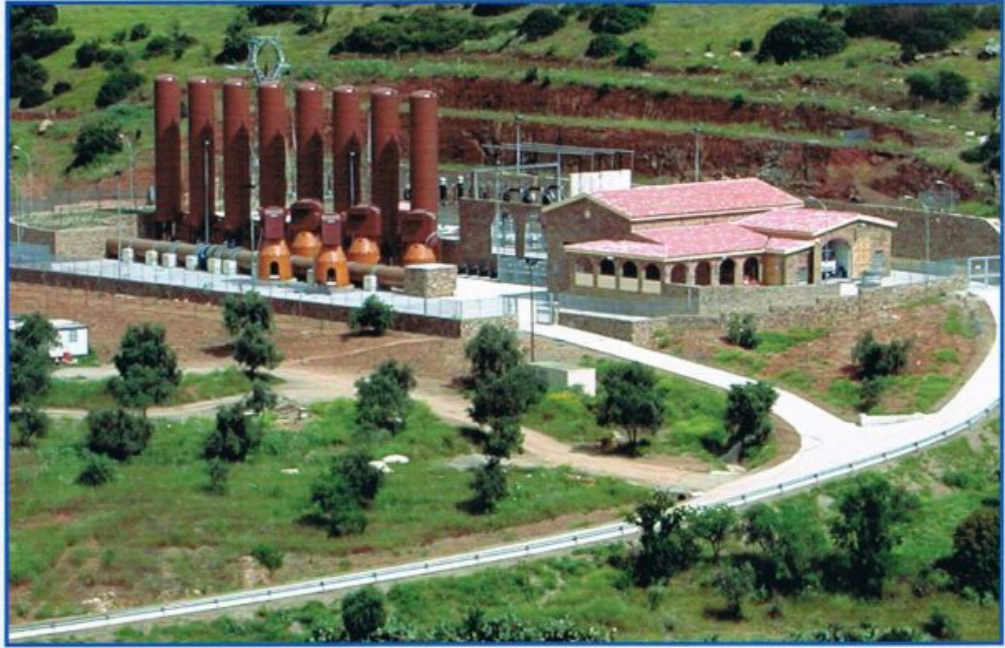
Veduta dell'impianto da sud
